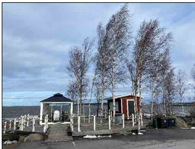
Kuva 6: Cafe Kallon rakennuksia kaava-alueen pohjoisosassa.
