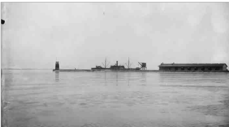
Kuva 12. Mäntyluodon satama kuvattuna Kallon suunnalta 1910–1920-luvulla. Satama-alueen aallonmurtajan kärjessä näkyy satamamajakaksi alun perin rakennettu Ryssäntorni. Kuva: Satakunnan Museon kokoelma.
