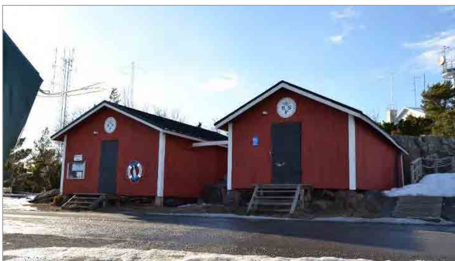
Kuva 39. Jollasuulit kuvattuna Kallontieltä. Pohjoisempi rakennus (kuvassa oikealla) on perustettu luonnonkivien, eteläisempi betonisten nurkkakivien varaan. Pohjoisempi suuli on sijainnut paikalla ainakin 1960-luvun alusta, toinen on rakennettu paikalle vuosien 2004 ja 2006 välillä rakennusarkkitehti Eeva Ruissalon piirustusten mukaan. Kuvannut KT.
