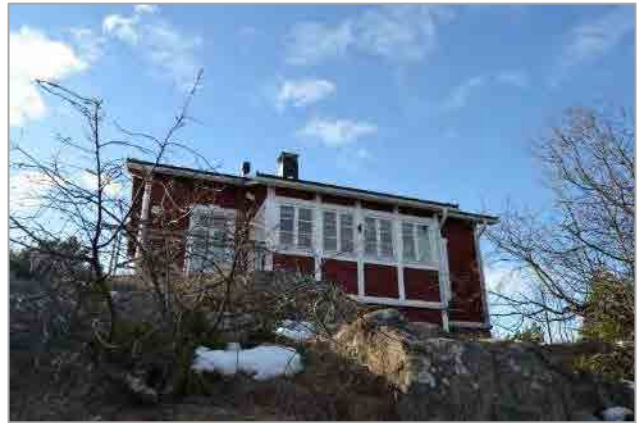
Kuva 34. Entinen luotsivartiotupa kuvattuna Kallontieltä maaliskuussa 2022. Kuisti muutettiin 1990-luvun korjaustöiden yhteydessä. Kuvannut KT.
