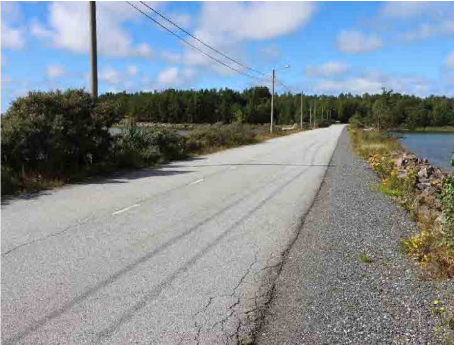
Kuva 1. Kalloa mantereeseen yhdistävä pengertie kuvattuna Mäntyluodon suunnasta.
