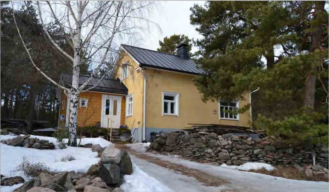
Kuva 47. Entinen öljysatamanhoitajan asuinrakennus maaliskuussa 2022. Kuvannut KT.
