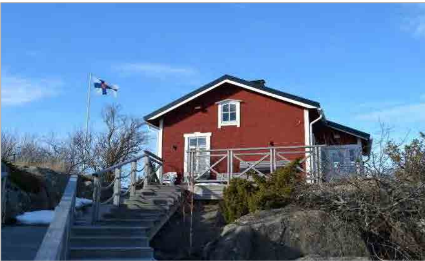
Kuva 37. Luotsivartiotuvan eteläinen pääty. Kuvannut KT.
