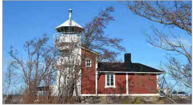
Kuva 20. Kallon majakka kuvattuna etelästä maaliskuussa 2022.
