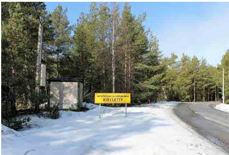
Kuva 14. Muuntamorakennus sijaitsee sisääntulotien läheisyydessä epävirallisen parkkipaikan reulla.
