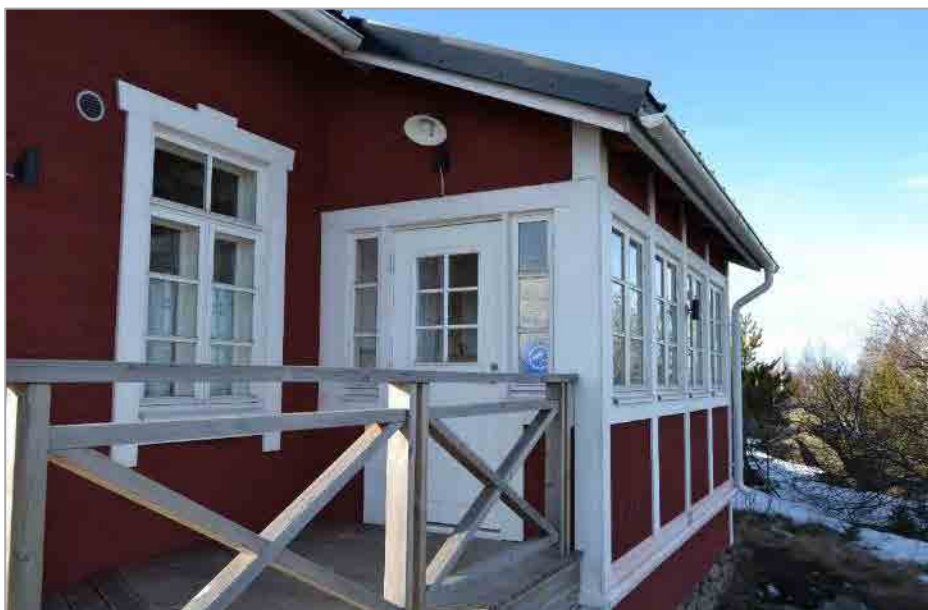
Kuva 38. Luotsivartiotuvan itäisivulla sijaitsee kuisti. Kuvannut KT.
