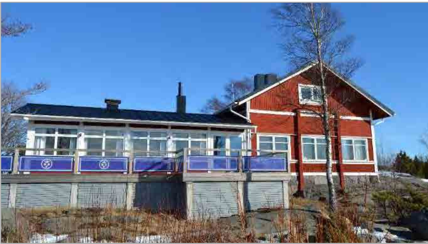
Kuva 28. Paviljongirakennus kuvattuna meren puolelta. Laajennusosan edustalla on betonipaalujaan varaan perustettu terassi. Kuvannut KT.
