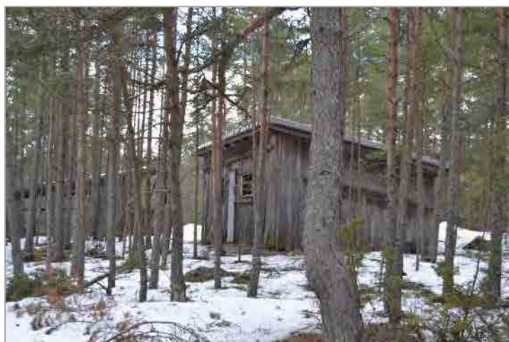
Kuva 49. Asuinrakennuksen takana sijaitsevat varistorakennus ja katos. Kuvannut KT.
