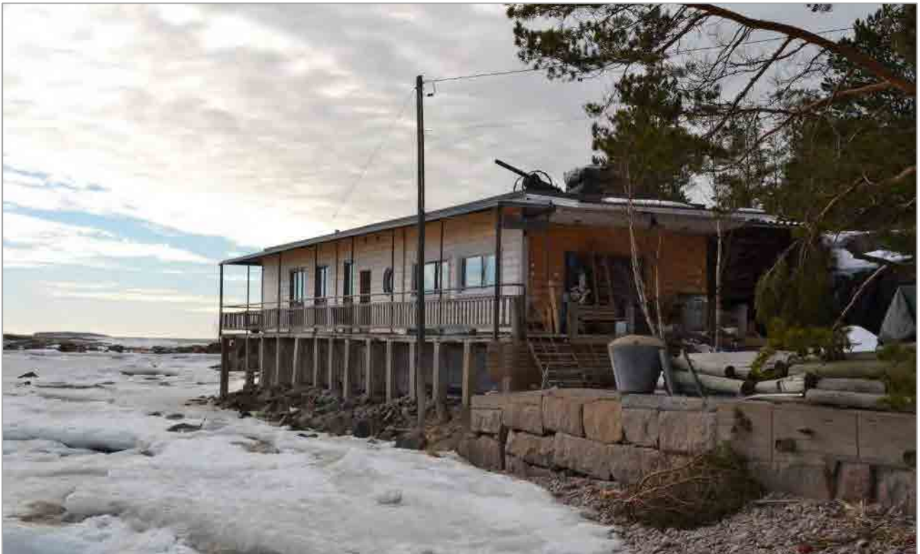
Kuva 46. Entisen öljysataman rakennus Mäntykallon etelärannalla. Kuvannut KT.
